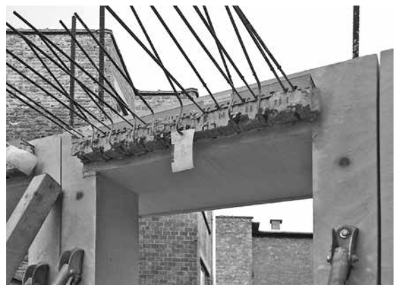
thermische wapeningskorf i.f.v. aanstorten vloerplaat
