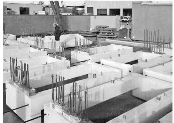
gevelementen klaar voor inspectie
