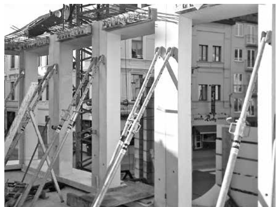
gevelementen geplaatst met trekchoren
