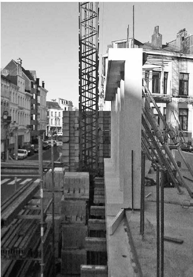
stapeling gevelementen voorgevel
