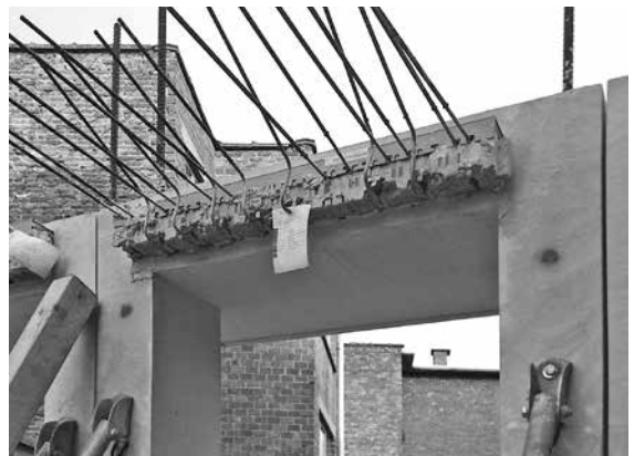
cages d'armature thermique pour le bétonnage de la dalle
