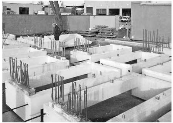
éléments de façade prêts pour l'inspection
