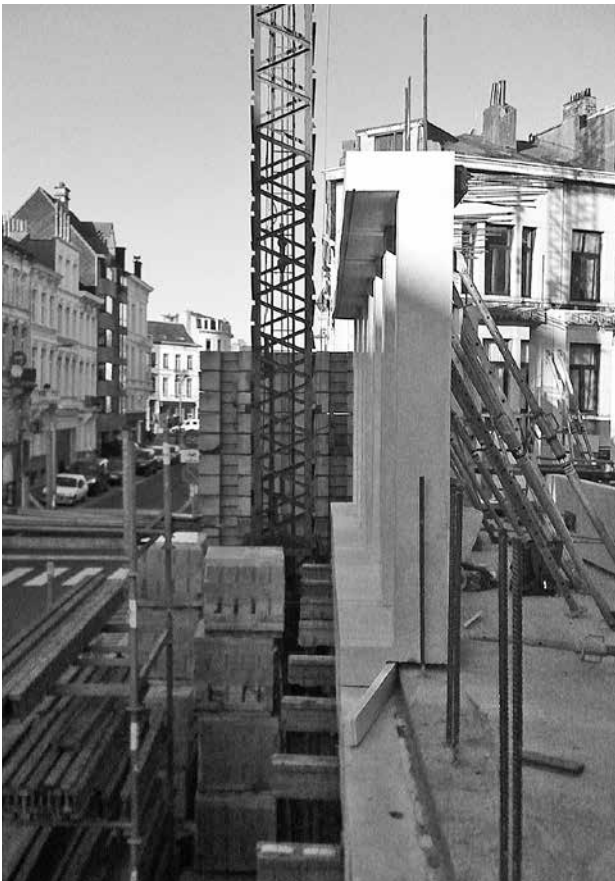
empilement d'éléments de la façade avant
