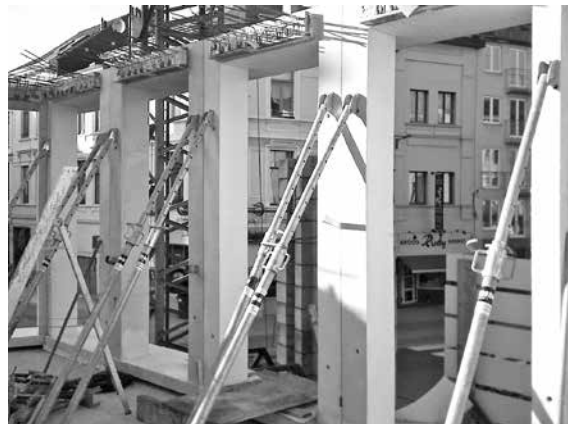
éléments de façade posés avec tirants
