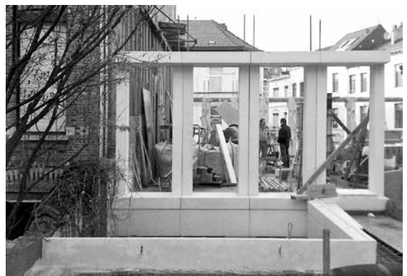
empilement d'éléments de façade au patio
